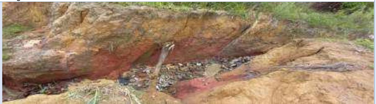
Imagem com detalhe do erosão em talude.
